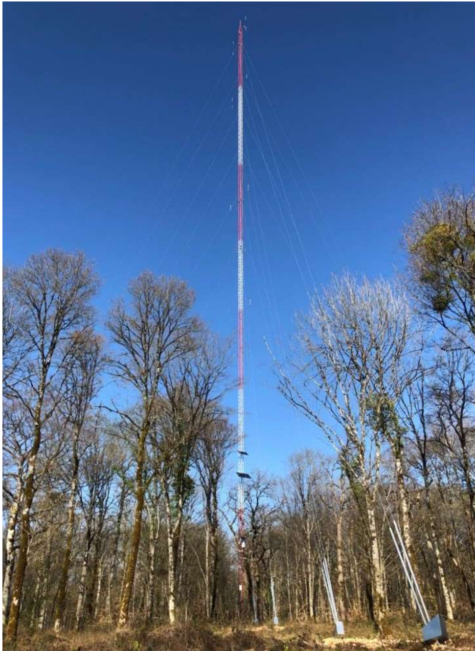
Photographie du mât de mesure installé à Marbéville
